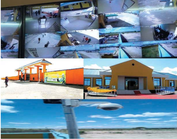
Picha Na. 13: Muonekano wa Mfumo wa Ulinzi wa CCTV kamera, Jengo la Kituo cha Pamoja na Ukuta Kuzunguka machimbo ya Tanzanite Mirerani – Manyara
