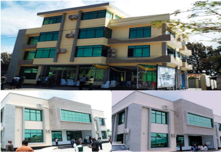
Picha Na. 9: Baadhi ya Vituo vya Umahiri kati ya Vituo Saba Vilivyojengwa katika Mikoa Mbalimbali Nchini
