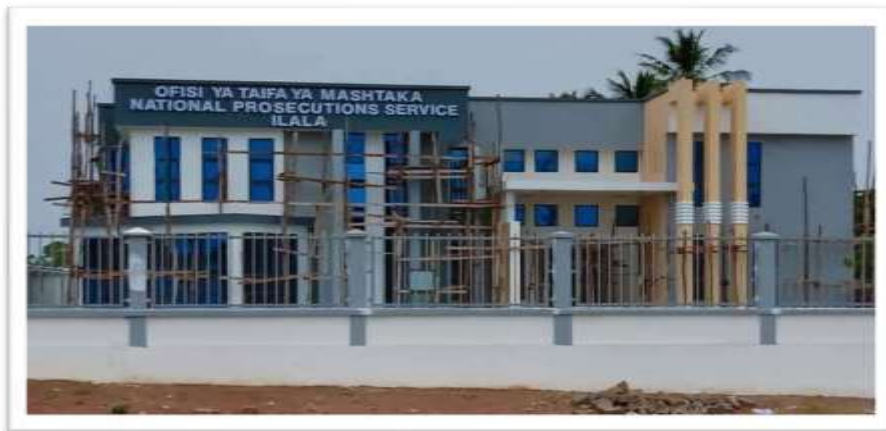
Picha Na. 13: Ujenzi wa Jengo la Huduma Jumuishi za Sheria linalojengwa na Ofisi ya Taifa Mashtaka katika Mkoa wa Kimashtaka wa Ilala, eneo la Kinyerezi, ukiendelea kukamilishwa.
