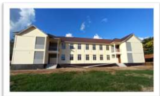
Hosteli -Mpwapwa (Mbele)
