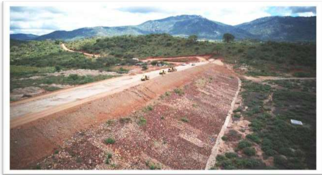
Picha Na.7: Ujenzi wa tuta la bwawa katika Mradi wa Umwagiliaji - Membe Dodoma
